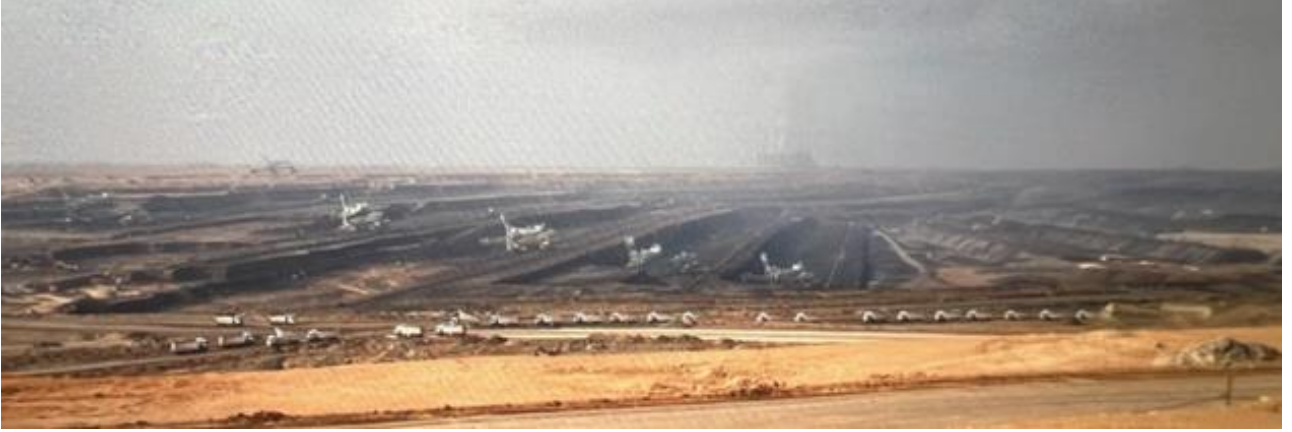
Şekil 1. AEL Kışlaköy İşletmesi DKE kazı ve nakliye sisteminden görünüm.
